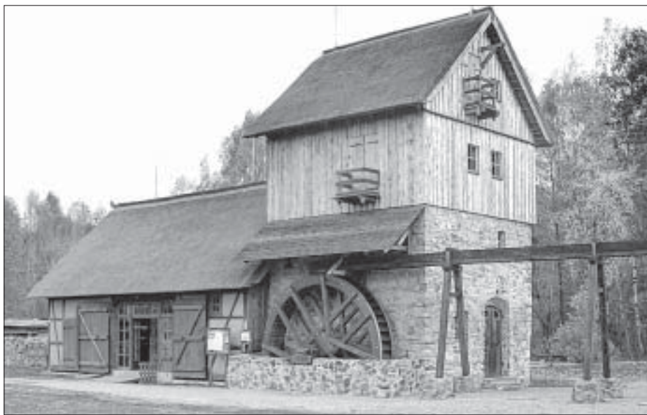
Znowa natwarjeny Čorny młyn w Čornym Chołmcu
