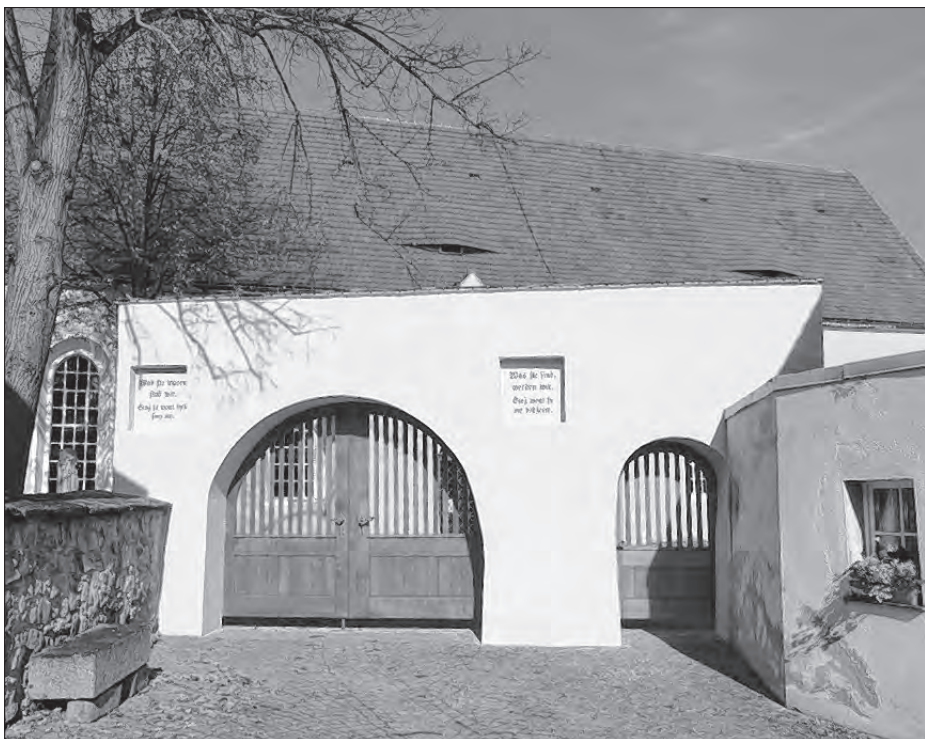
Wobnowjeny južny zachod na Njeswaćidlski stary kěrchow
